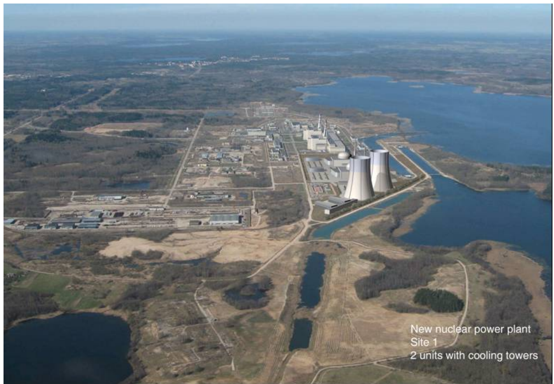
5.5-1. attēls. Pirmās celtniecības vietas fotomontāža ar diviem AES reaktoriem un dzesēšanas torņiem.
