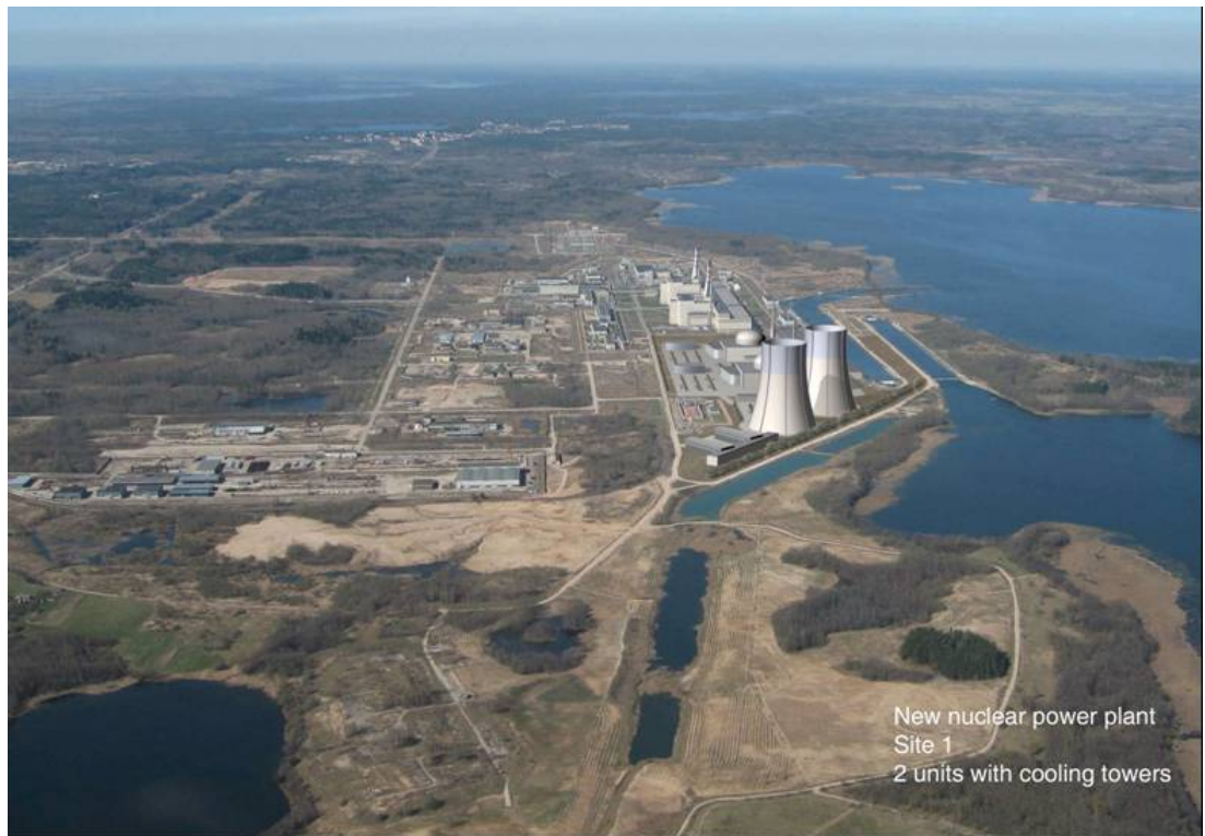
Рис. 5.5-1. Фотосхема Площадки 1 с двумя установками АЭС и охладительными башнями.
